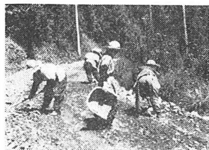
〔市の瀬地区の県道補修〕
