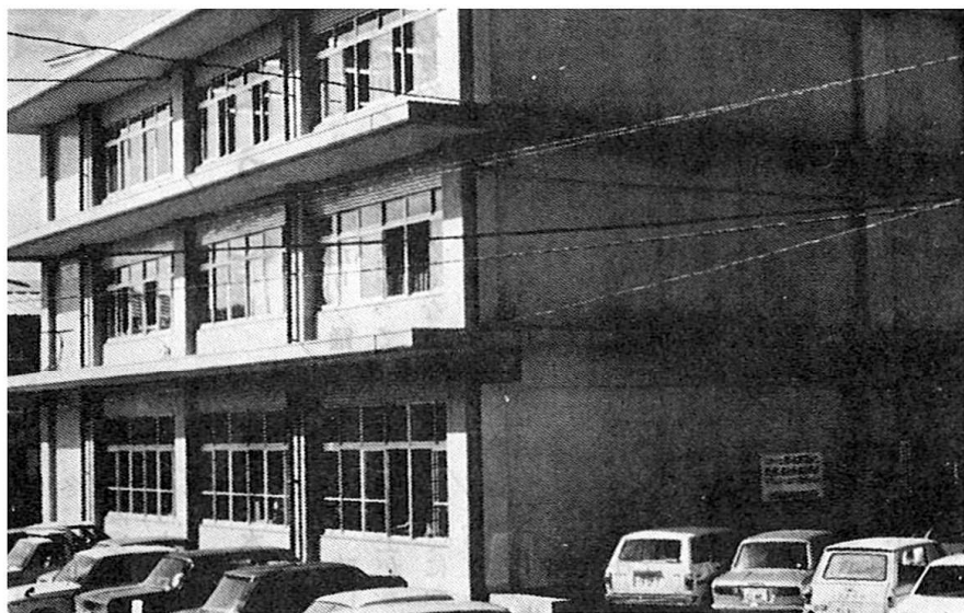
9月15日 日田市中庭に完成した広域会館
