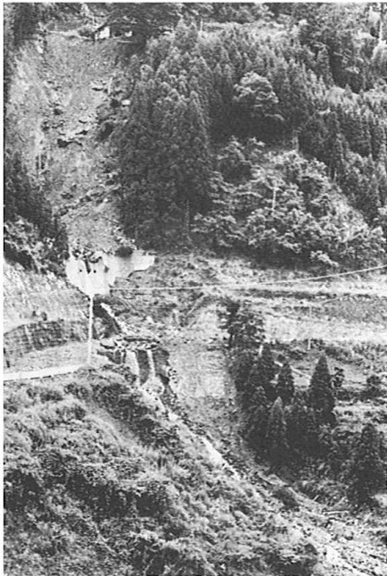
一万 m 3 土砂流出の二又決壊現場
