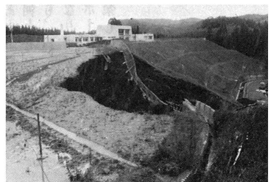
グラウンドの土羽の欠壊 (津江中)
