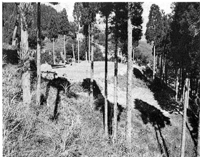
展望台遊歩道(園地)工事着手
