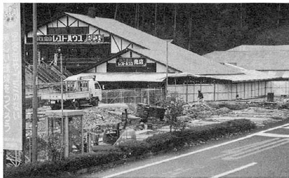
▲金採取場建設工事
