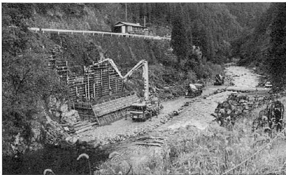
▲村道黒谷線改良工事（橋梁）
