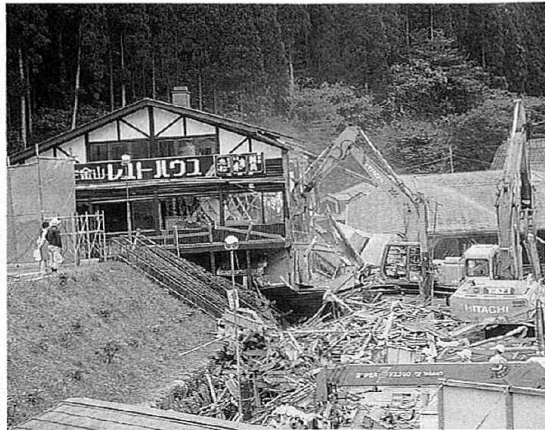
▲本体工事に備える撤去作業
