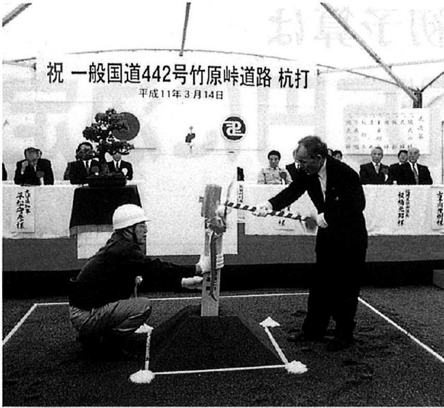
杭打を行う坂本村長
