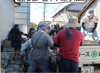
倒れたブロック塀の積込
